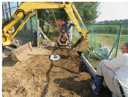
排水溝工事の様子
