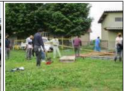
保健体育委員の方々には、廃棄資材の解体作業のご協力をいただきました。
