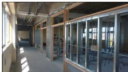
校舎内は、コンクリート管体に枠が付き、教室の形ができそうです
