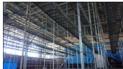
体育館内全体に足場が組み立てられ、壁は明るい色調の板になるようです
